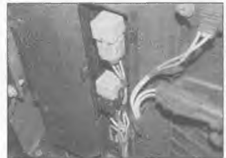
6.12 Cooling fan relays
